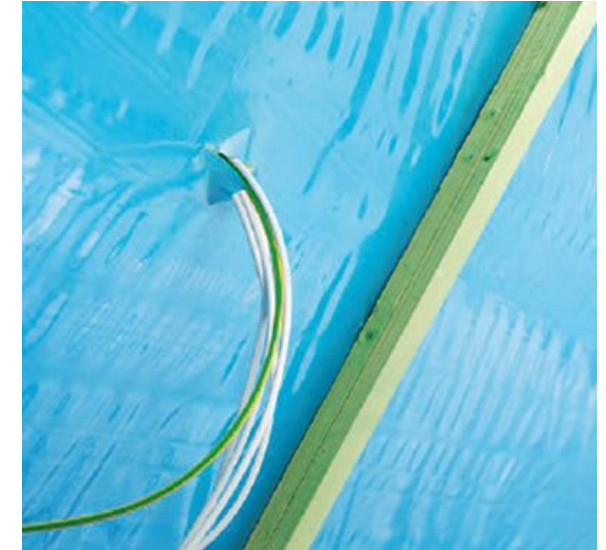
Die Leitungen werden durch die Luftdichtung des Gebäudes geführt. Diese Durchführung muss dauerhaft luftdicht verschlossen werden.
